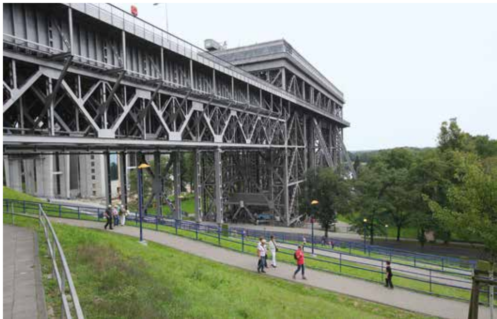
Unter der Kanalbrücke
