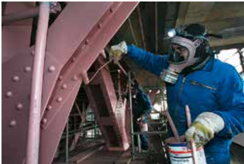
Korrosionsschutzarbeiten
